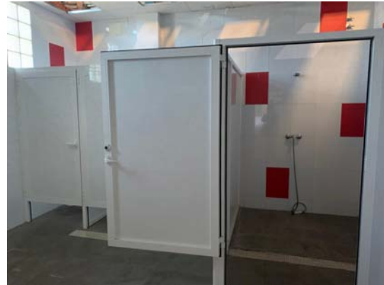
Imagen – Interior de vestuarios y aseos. Febrero 2022.
